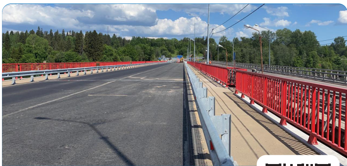
Мост через реку Вуокса на км 36+993 А-181 «Скандинавия», Выборгский р-н
